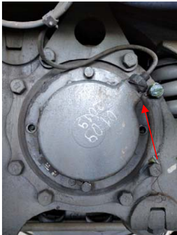
Рисунок Г.5 – Установка датчика вводом кабеля по направлению вверх (неправильная установка)
