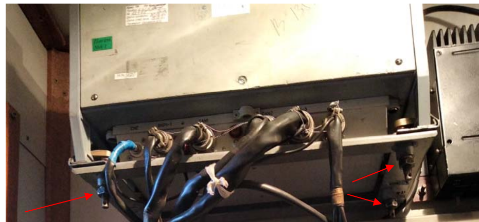
Рисунок Г.7 – Установка блока БЭЛ-У на кронштейне
